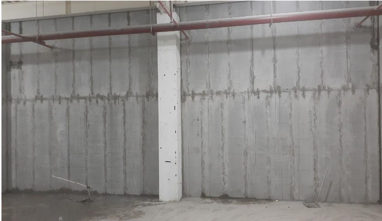
Hình ảnh bề mặt tường sau khi mài mạch tiếp giáp
