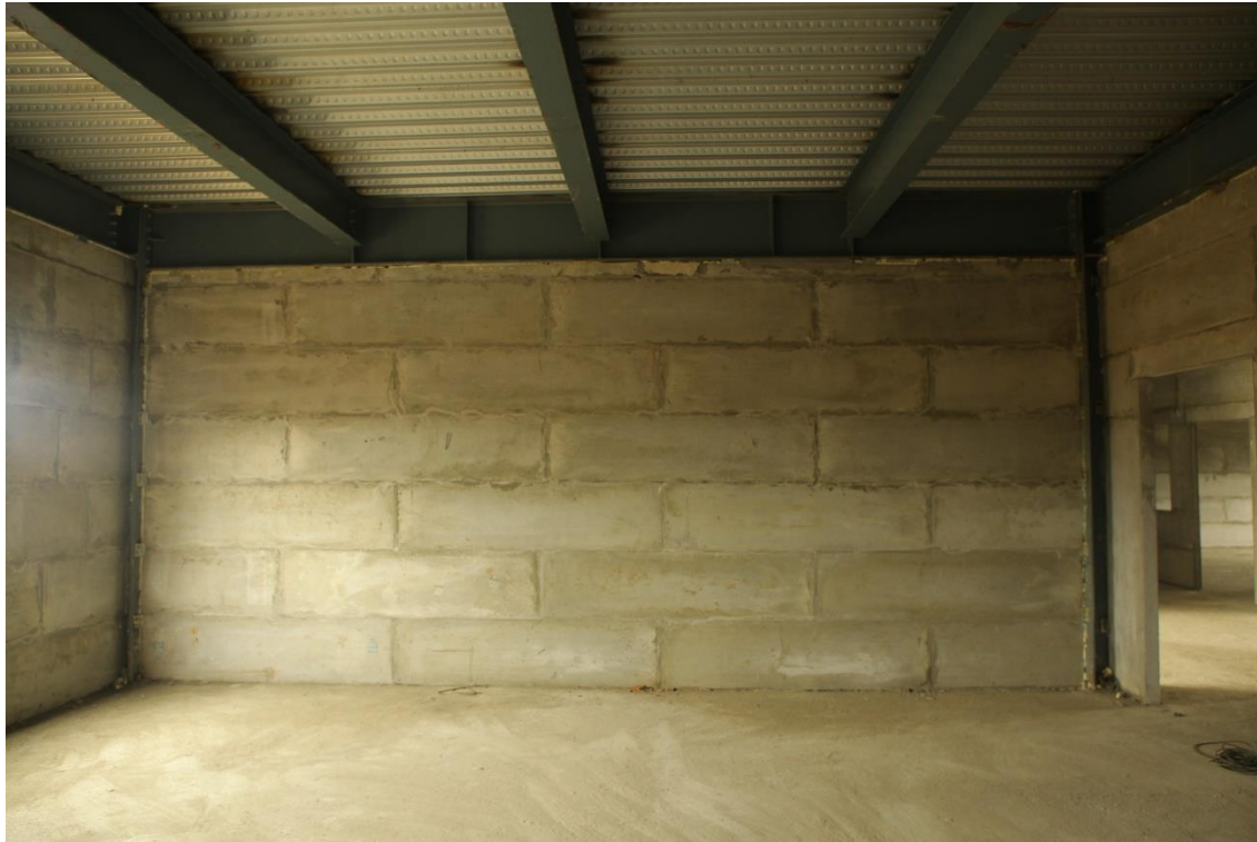
Hình ảnh bề mặt tường sau khi mài mạch tiếp giáp
